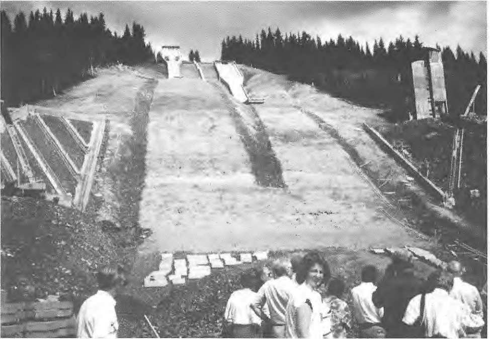
Befaring av OL-anleggene - Lysgårdsbakken hoppanlegg, Lillehammer 13. juni 1992. Eva Sandberg i forgrunnen.
